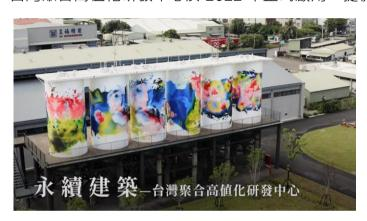
建築本體採用舊倉庫改建,減少重建造成的碳排消耗。儲槽彩繪與台灣藝術家江賢二老師合作,底色使用台聚全效型隔熱塗料,此為水性環保塗料,有效降低槽體表面溫度。
