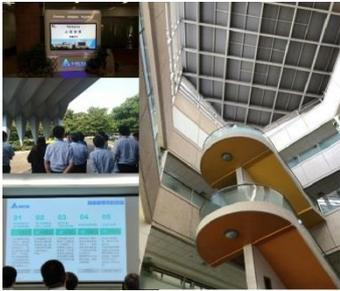
台達電台南一期廠辦，2006 年獲得第一座內政部 EEWB 評估系統九大指標的綠建築。啟用後持續改善，2009 年升格為“鑽石級”綠建築。設計規劃之初已導入綠建築概念，包含方位設計、天井通風照明、雨水回收（灌與浴廁沖水）搭配雨量偵測停止澆灌、建築外觀、窗台設計、生態池等等，可以作為未來蓋本公司和集團新建築的參考。
