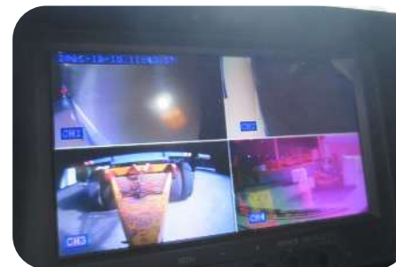
▲ 車輛記錄設備功能確認
