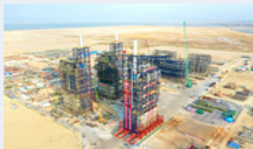
▲ 乙烯裂解爐整體模組搬運安裝
