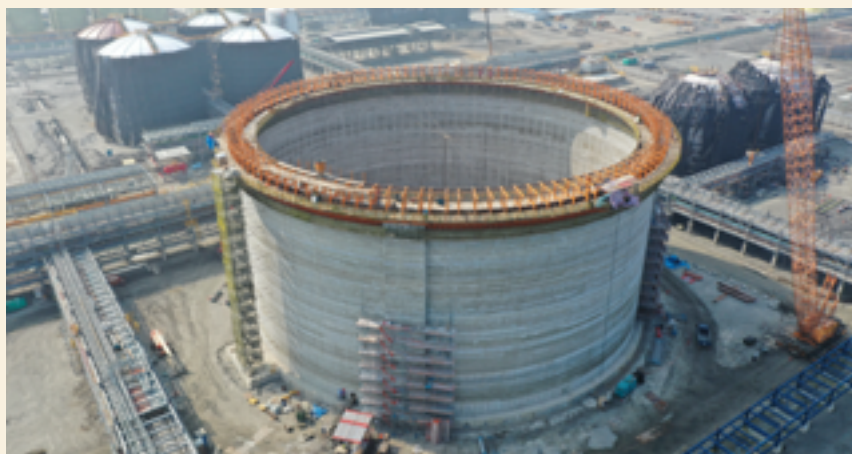
▲ 外槽完成滑模爬升 28M，目前進行預力施作及內槽焊接施工。
