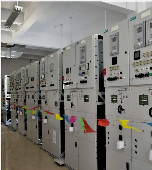
110kV 變電站設備安裝
